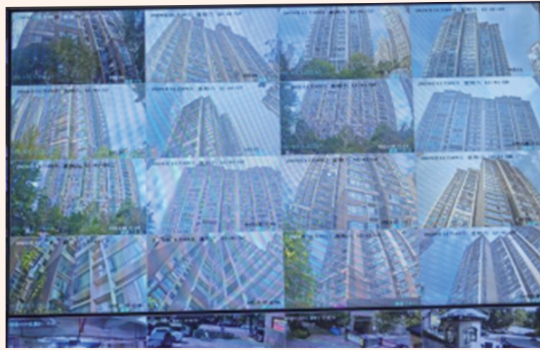
华晨御园小区今年9月改造安装了30个防高空抛物高清监控。
