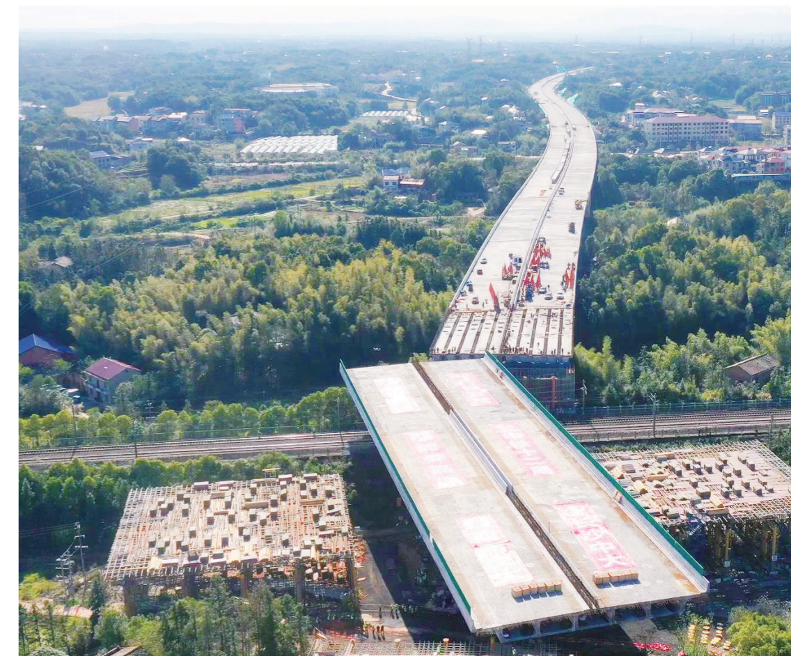
转体架设中的醴娄高速上跨沪昆铁路桥。记者/廖明 摄
