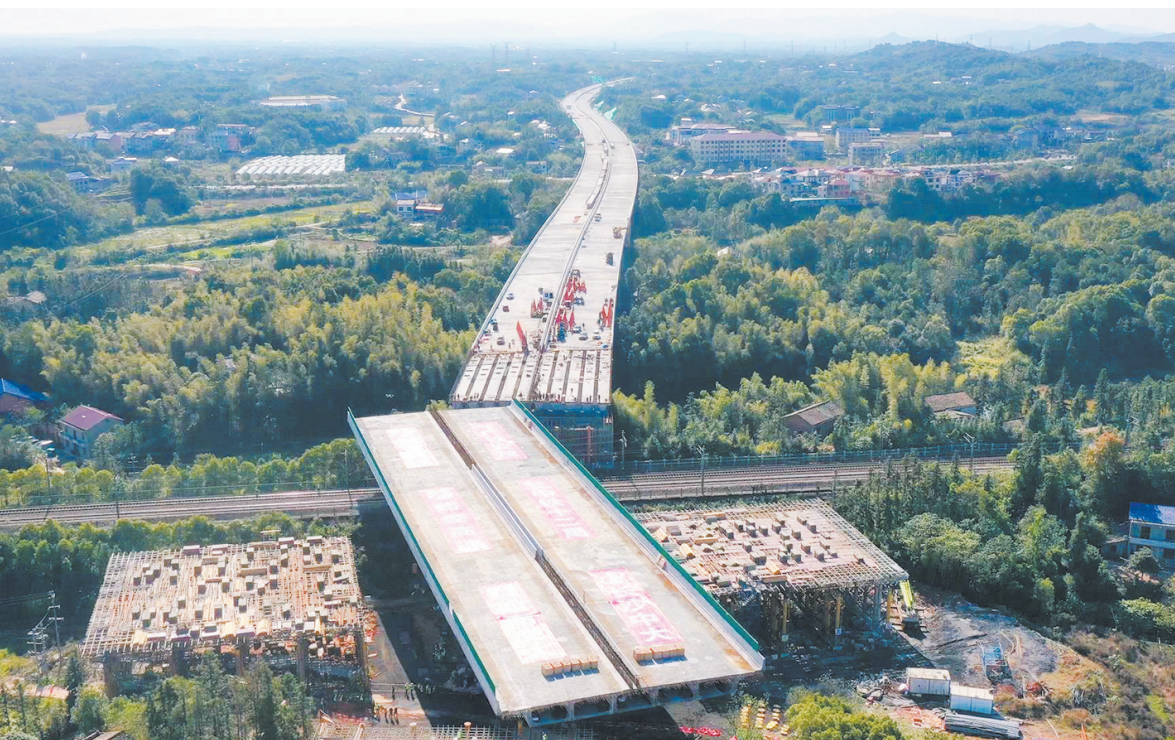
转体架设中的醴娄高速上跨沪昆铁路桥。株洲日报全媒体记者/廖明 摄
