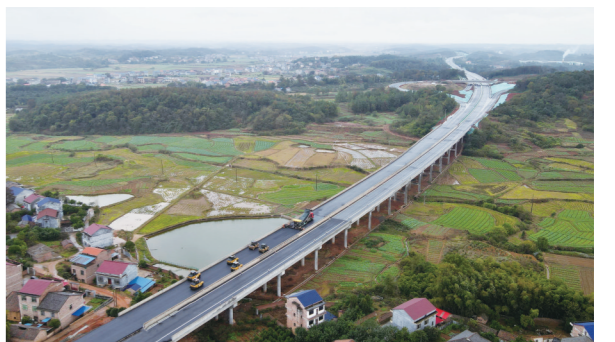
茶常高速路面1标完成主线沥青上面层摊铺。通讯员/黄醒 摄
