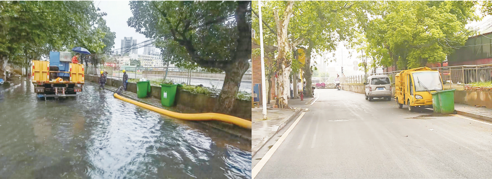
荷塘区戴家岭路海绵项目建设前后对比。 通讯员 供图
