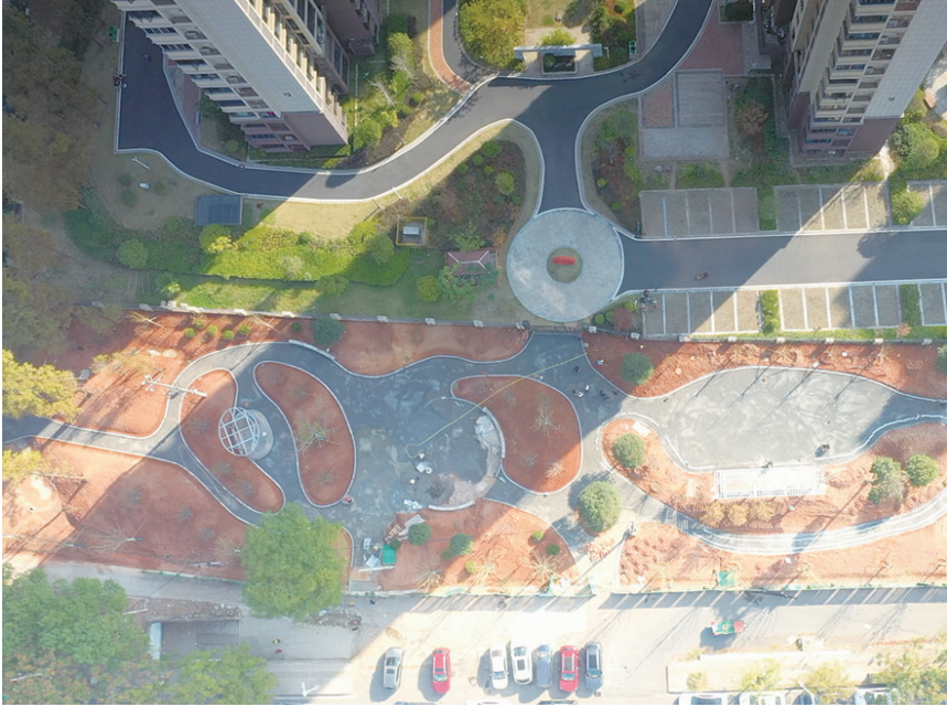
航拍东方名都小游园项目建设现场。记者/吴琦 摄
