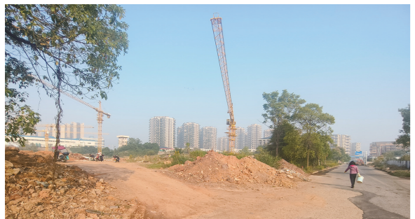
目前废弃工地仍可自由进入。 记者/廖智勇 摄
