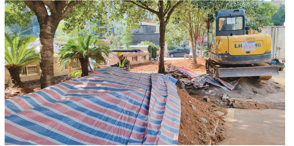
白鹤园雨污分流改造施工现场。
