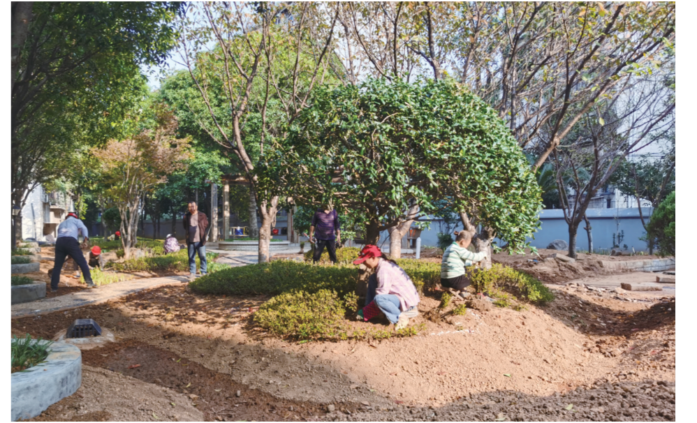
市科技局院内的海绵城市建设与雨污分流改造现场。
