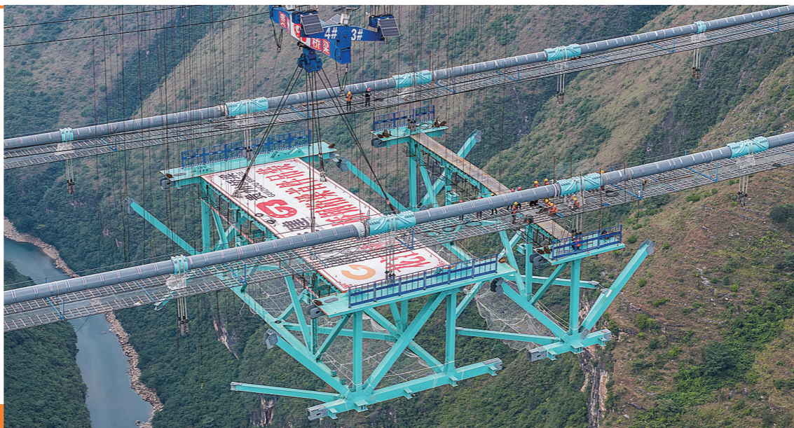
花江峡谷大桥的首件钢桁梁吊装抵达指定位置(11月4日报，无人机照片)。据新华社
