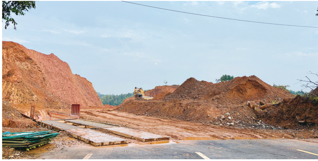
电力生产检修基地项目现场。记者王娜摄
