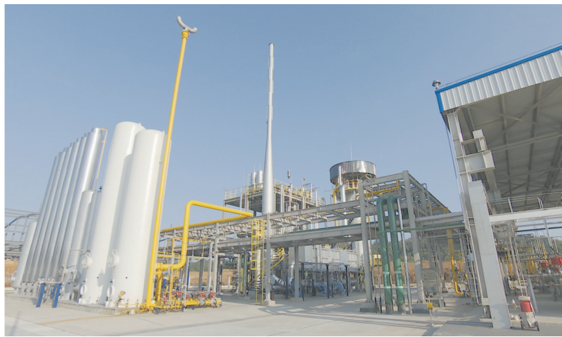
图为湘钢梅塞尔株洲制氢项目现场。 株洲日报全媒体记者/陈正明 摄
