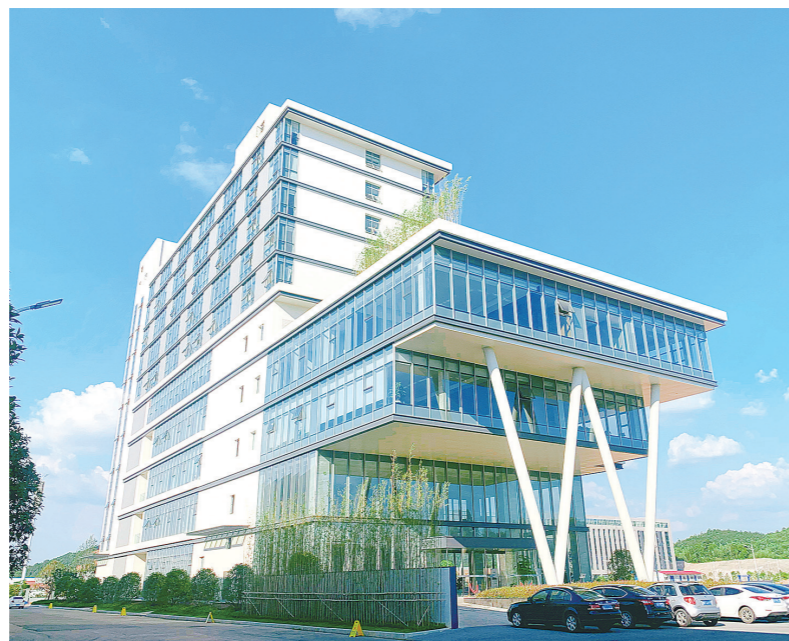
位于荷塘区的中天杭萧研发楼是我市首个钢结构装配式项目。记者/张威 摄(资料图)
