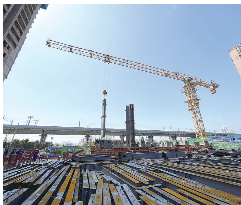
由钢结构打造的荷花家园一号楼。记者/张威 摄(资料图)
