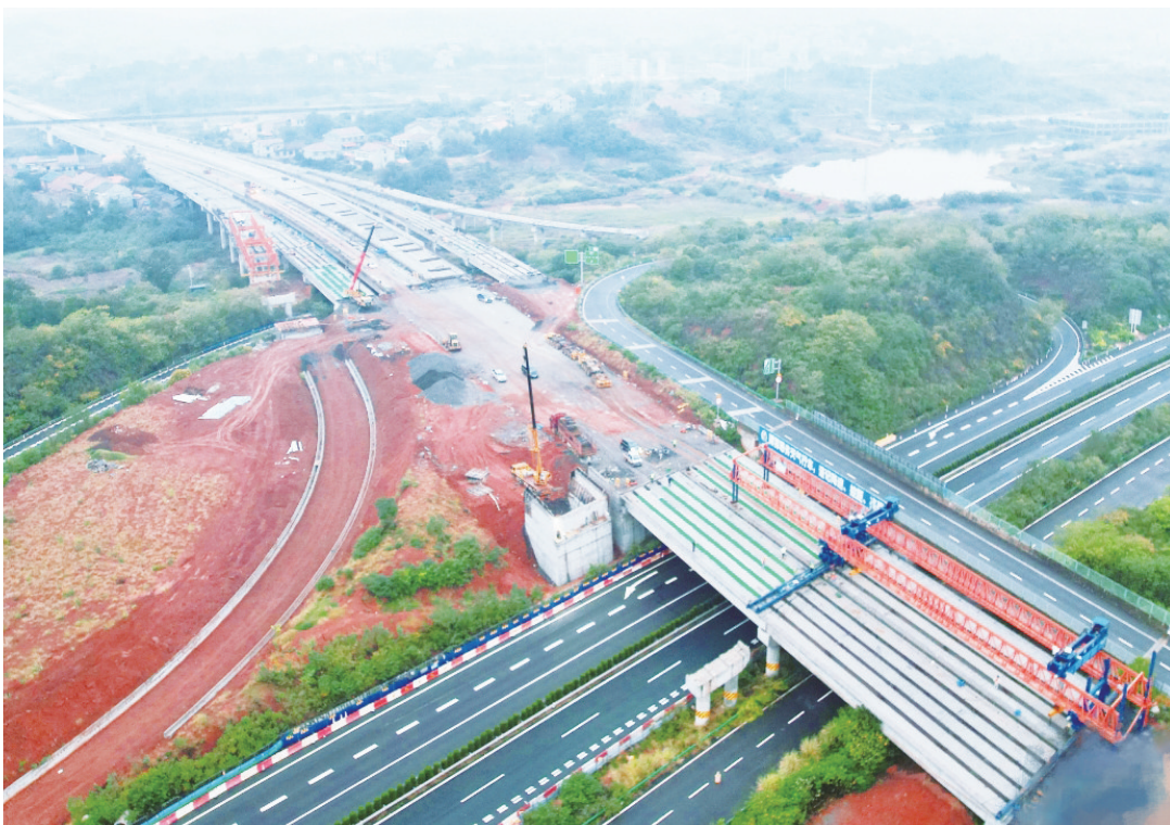
孟塘中桥最后一块预制梁架设到位。通讯员/黄醒 摄
