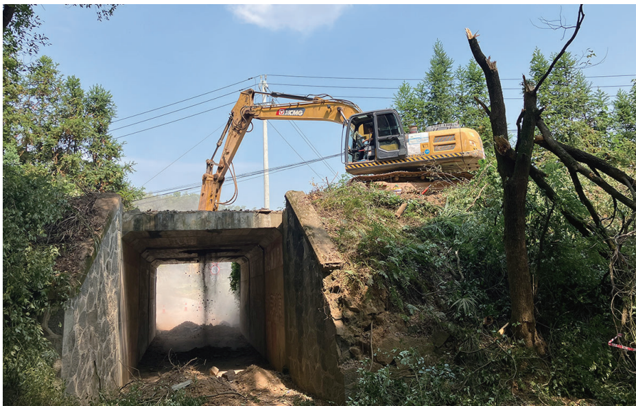
地机正在拆除涵洞顶部。记者姚时美摄
