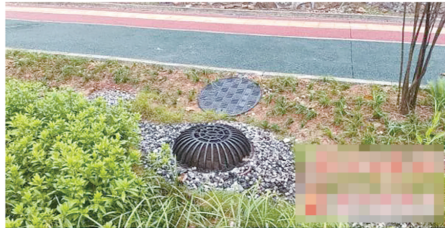
新塘路(北环大道—金桥路)设施带溢流井。资料图
