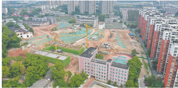
田心中学新建的2号楼教学楼已盖了三层。 记者/张威 摄
