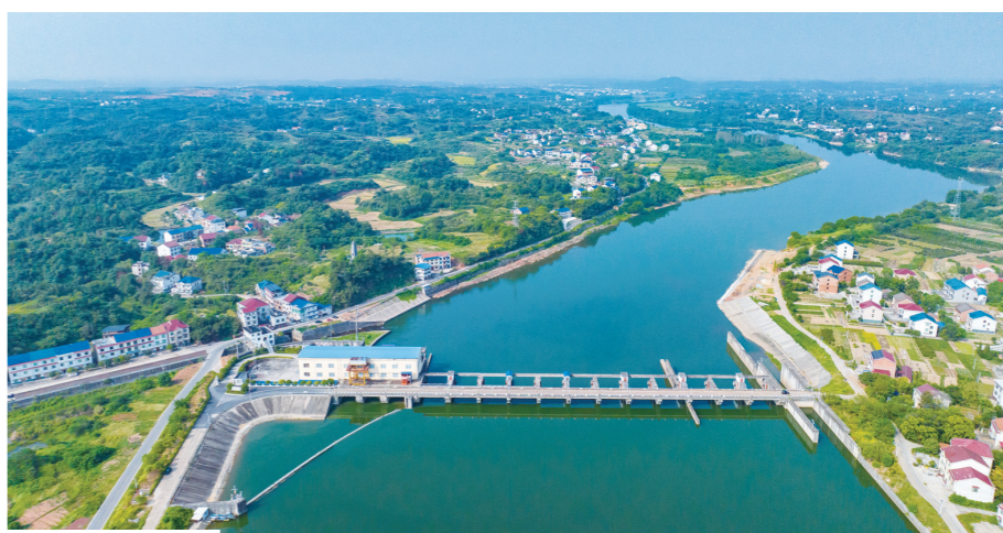
攸县桐坝电站是洣水流域第13个梯级开发点,总装机容量1.5万千瓦,年平均发电量5300万度,2021年成功创建全国绿色小水电示范电站。 株洲日报全媒体记者/谢慧 何威亮 摄
