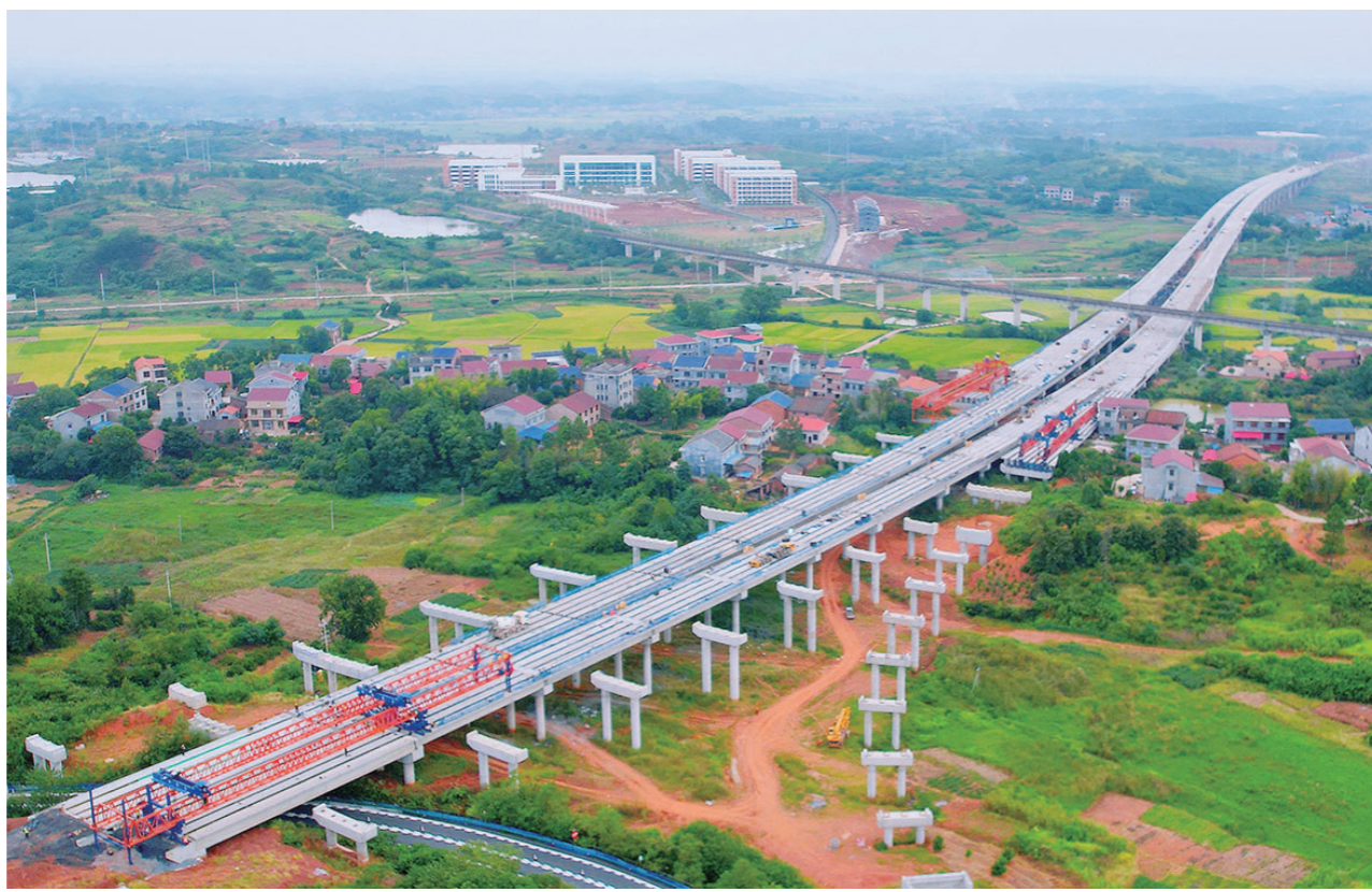
茶常高速孟塘特大桥全桥贯通。 通讯员/黄醒 摄
