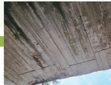
涵洞洞顶留下不少车辆刮痕。
