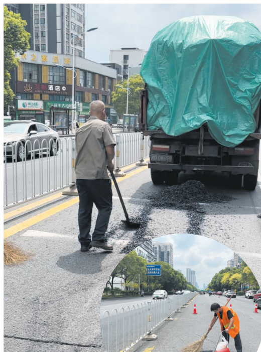
大量铁屑落在行车道上。记者/刘平 摄
