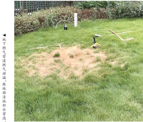
地下燃气管道出现泄漏,导致地面草皮枯萎。燃气公司供图
