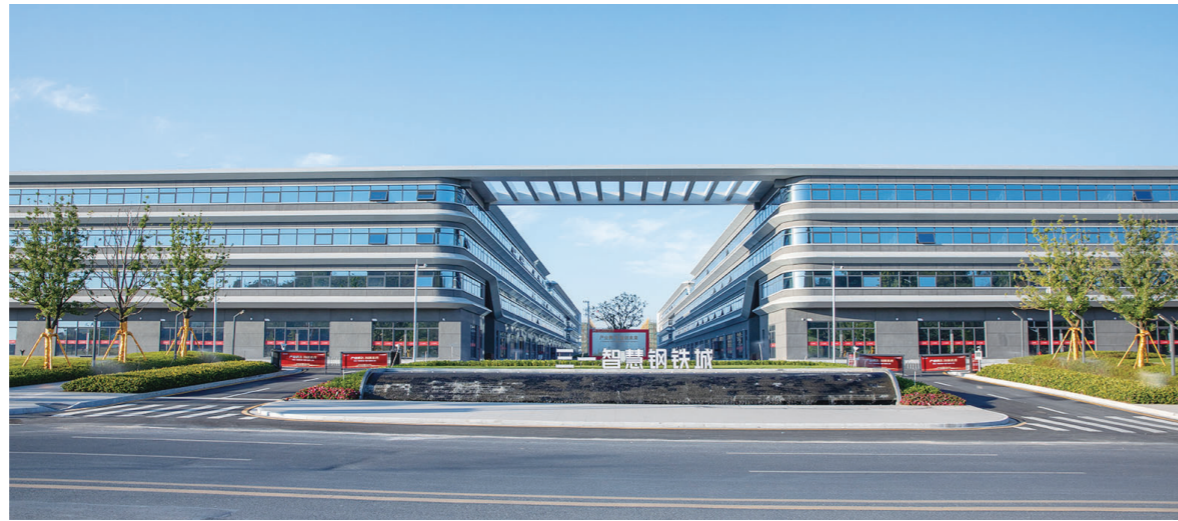
三一智慧钢铁城项目现场。受访者提供
