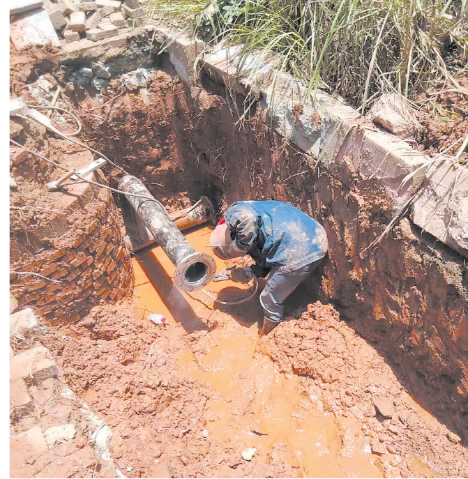
施工人员正在为企业更换大口供水管道。记者/张威 摄
