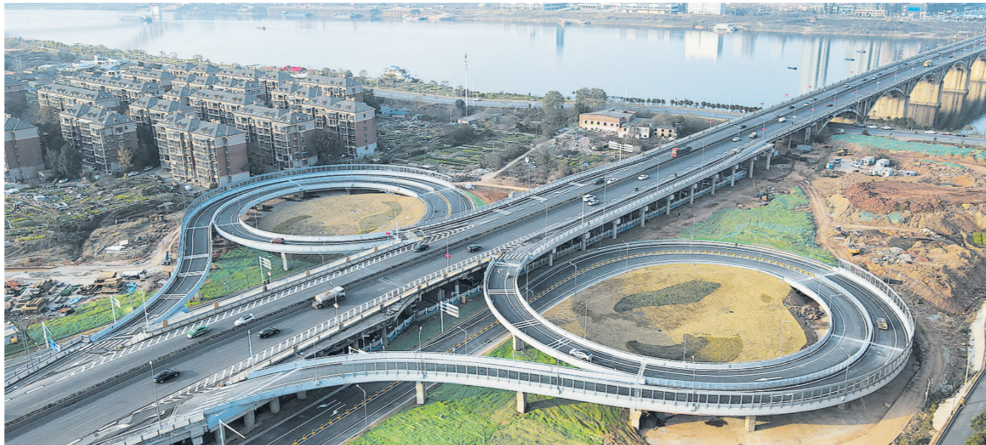
征地拆迁工作保障重大项目如期竣工,图为石峰大桥西匝道。记者/张威 摄
