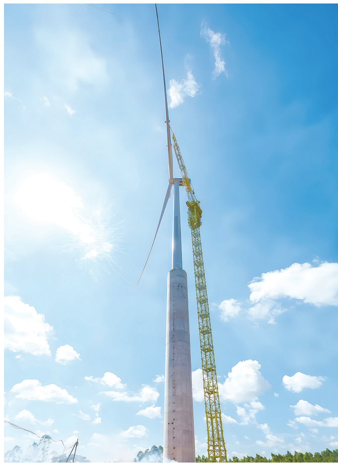
风电项目现场。
