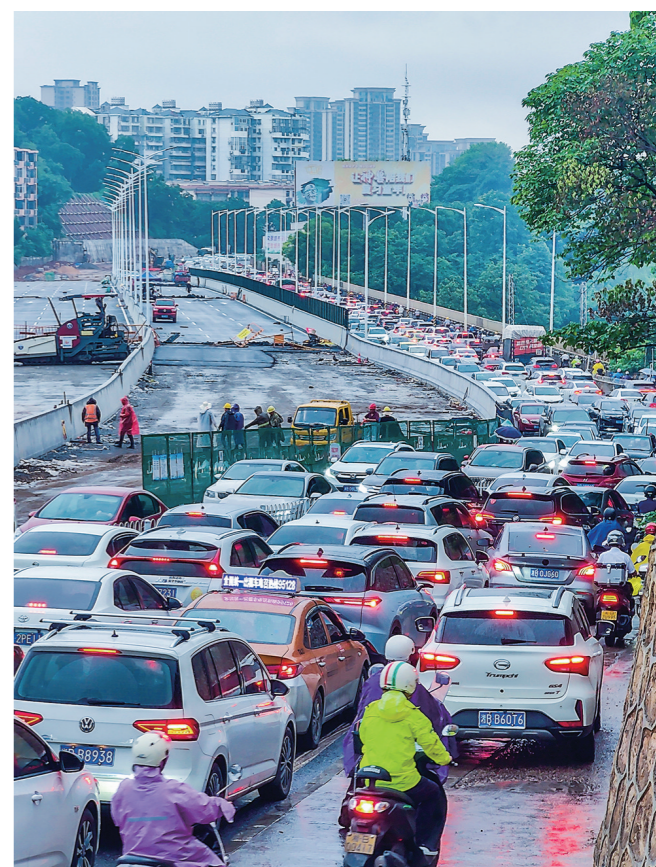
2024年6月17日,新桥还在加紧建设,老桥在早高峰时段的堵车场景。
