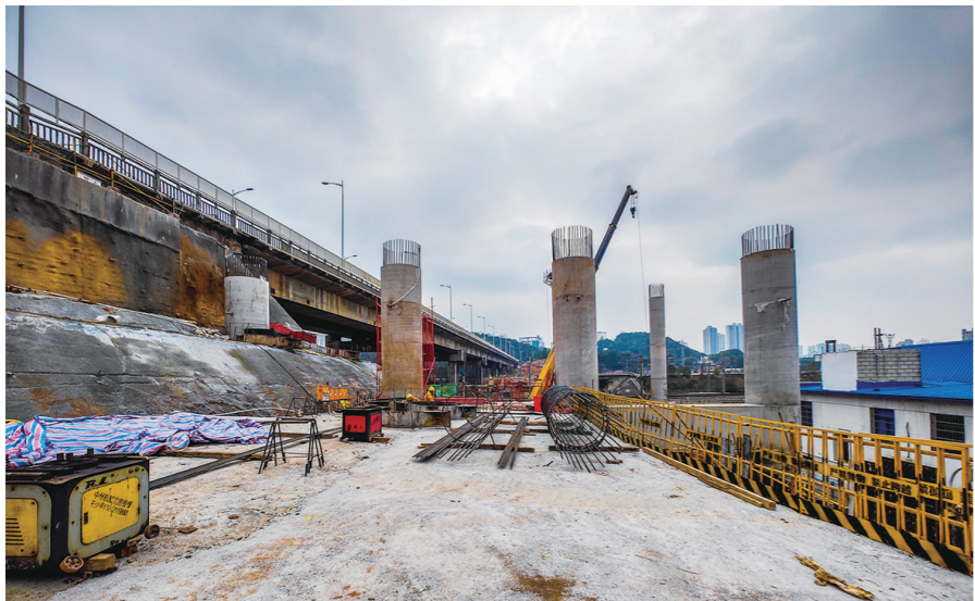
2023年2月24日,第一跨立柱建成,至年底,大桥拓宽工程完成全部26根桩基工程。
