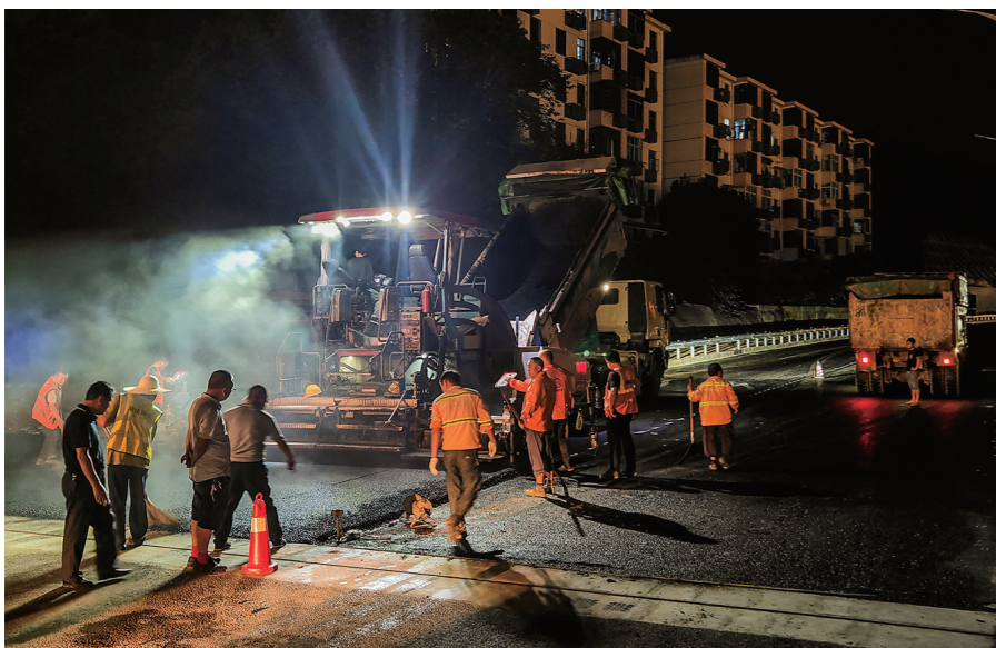
2024年6月28日,大桥北半幅路面在通宵铺设沥青,次日北半幅新桥开始通车。
