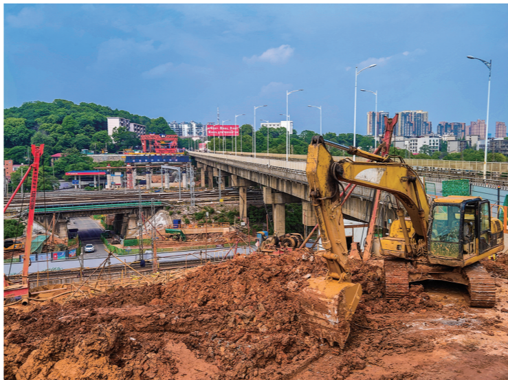
2023年5月12日,响田大桥西端,桥头接线工程施工场景。
