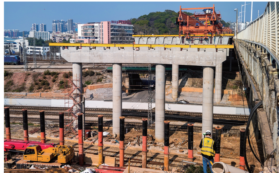
2024年3月11日,倒数第二跨箱梁开始架设,该跨的架设最为困难和紧张。
