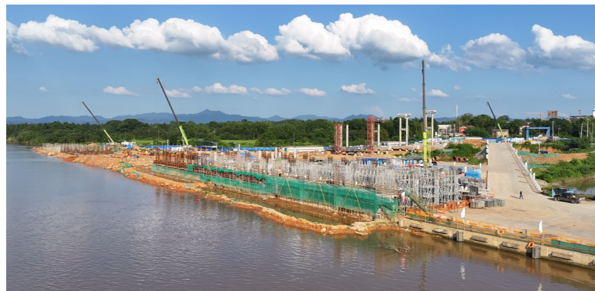
码头施工现场，通讯员/李琴露 摄
