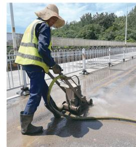
7月18日,工作人员在响田大桥老桥桥面绘制新标线。
