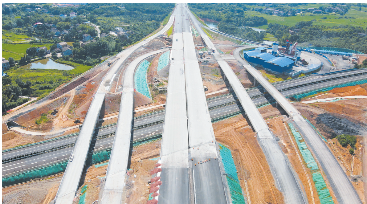
正在建设中的醴娄高速孙家湾枢纽。记者/廖明实 提供
