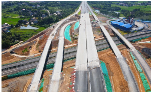
正在建设中的醴陵高速孙家湾枢纽。 记者/廖明 提供
