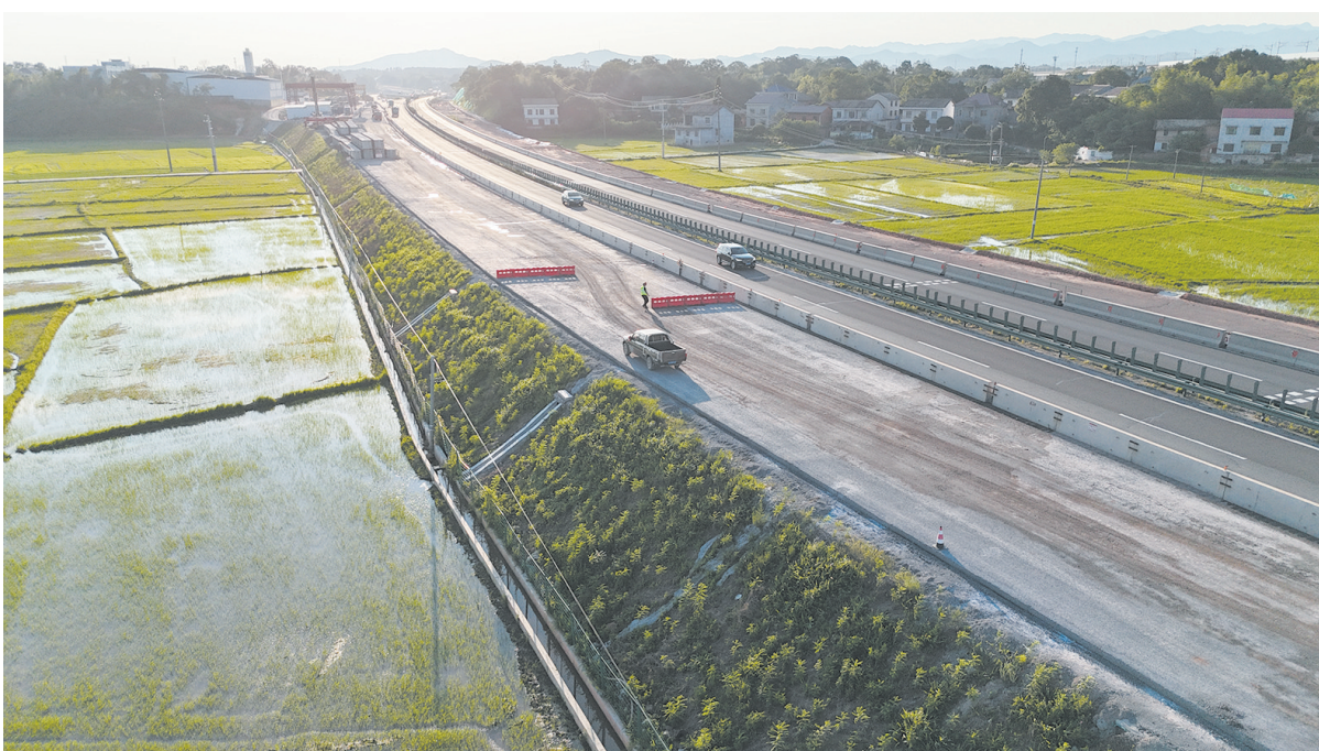
沪昆高速金醴段扩容改造现场。记者/廖明 供图
