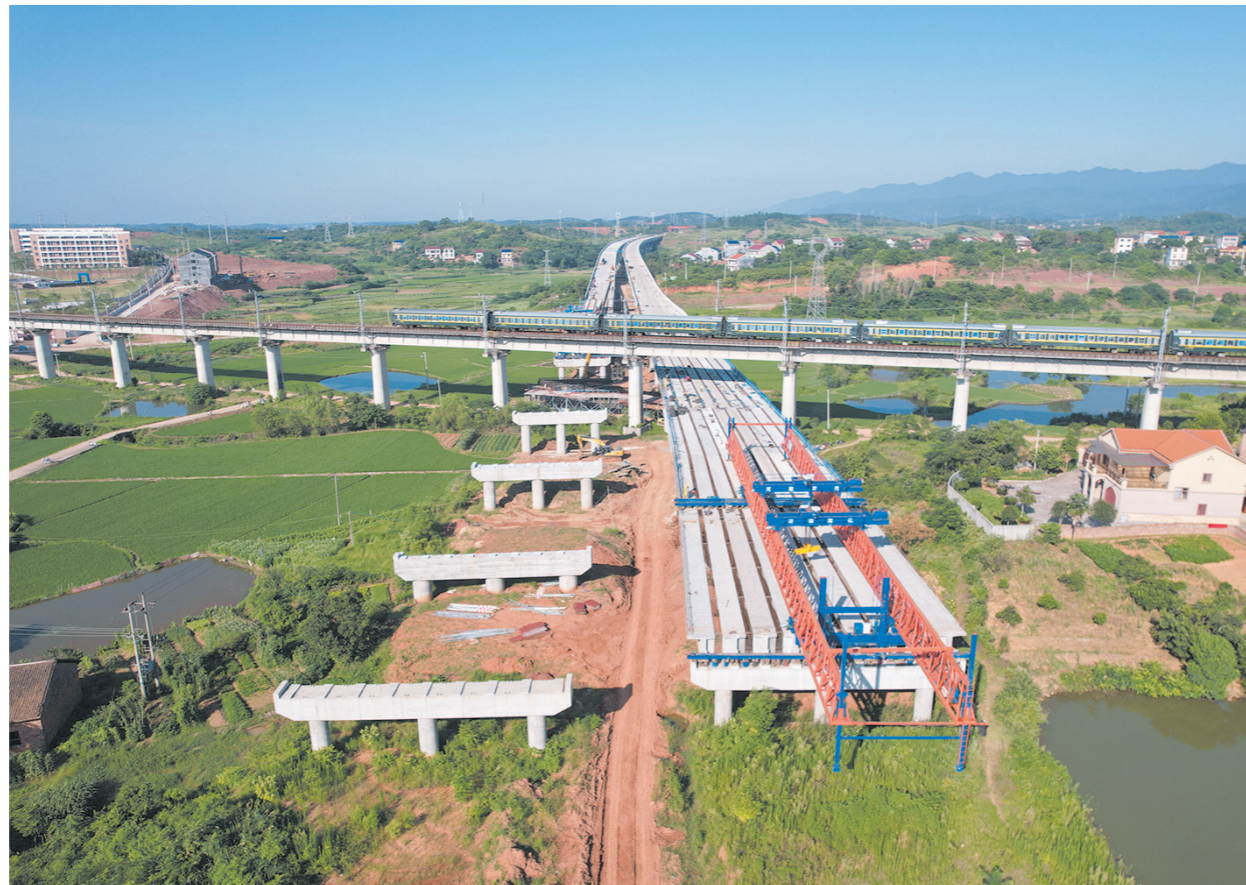
茶常高速孟塘特大桥架梁施工现场。记者/廖明 供图
