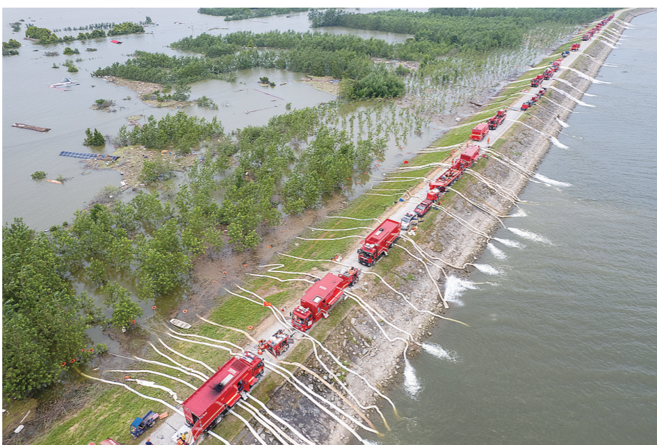
7月9日,在湖南华容县团洲垸洞庭湖大堤决口封堵作业中(无人机照片)。随着湖南华容县团洲垸洞庭湖大堤决口完成封堵,消防、应急等部门抢险人员抢抓时间在多个点位开始对团洲垸进行排涝作业。
