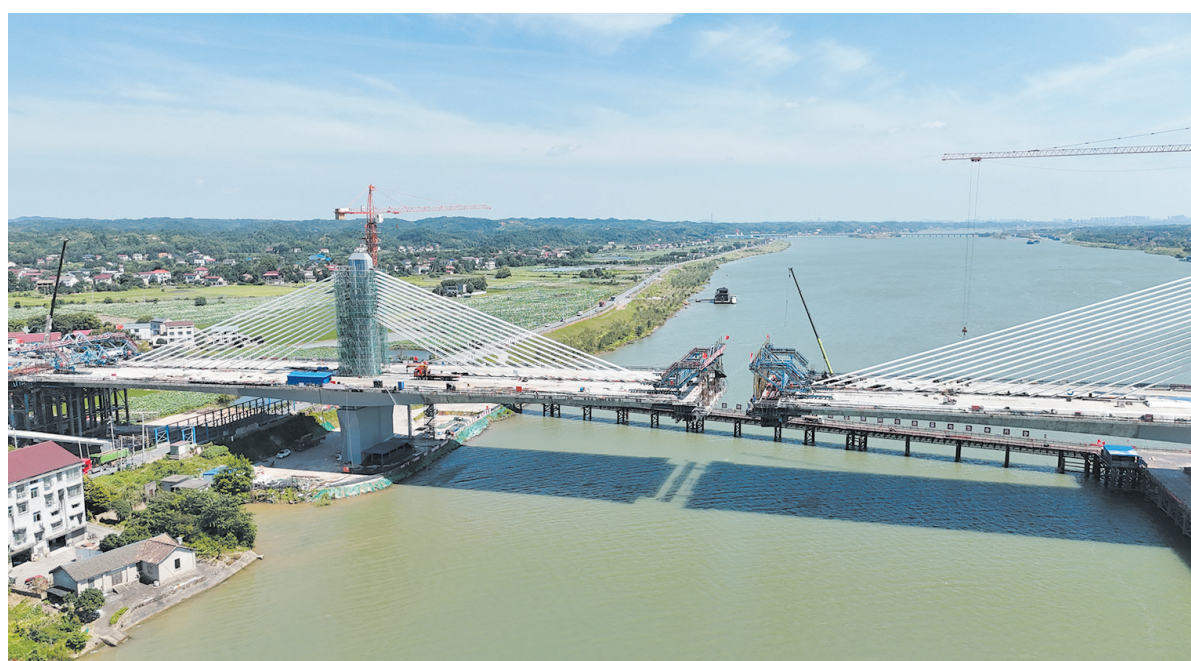
醴娄高速湘江特大桥梁项目建设现场。 株洲发布/龙泽平 摄
