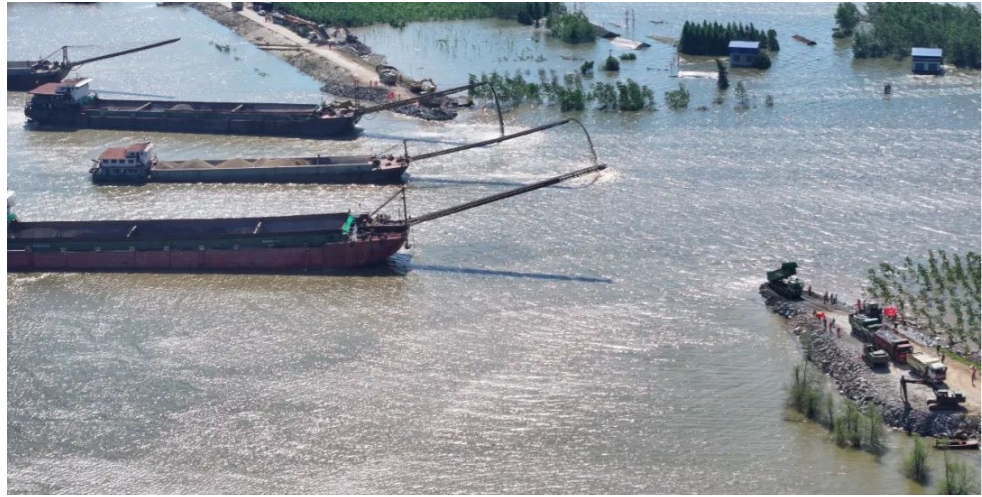
7月8日,在团洲垸洞庭湖大堤决口现场,抢险队伍在进行堵口作业。无人飞机照片。
