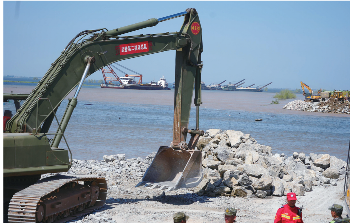
7月6日,武警某部在华容县团洲垸洞庭湖一线堤防进行封堵决口作业。新华社供图
