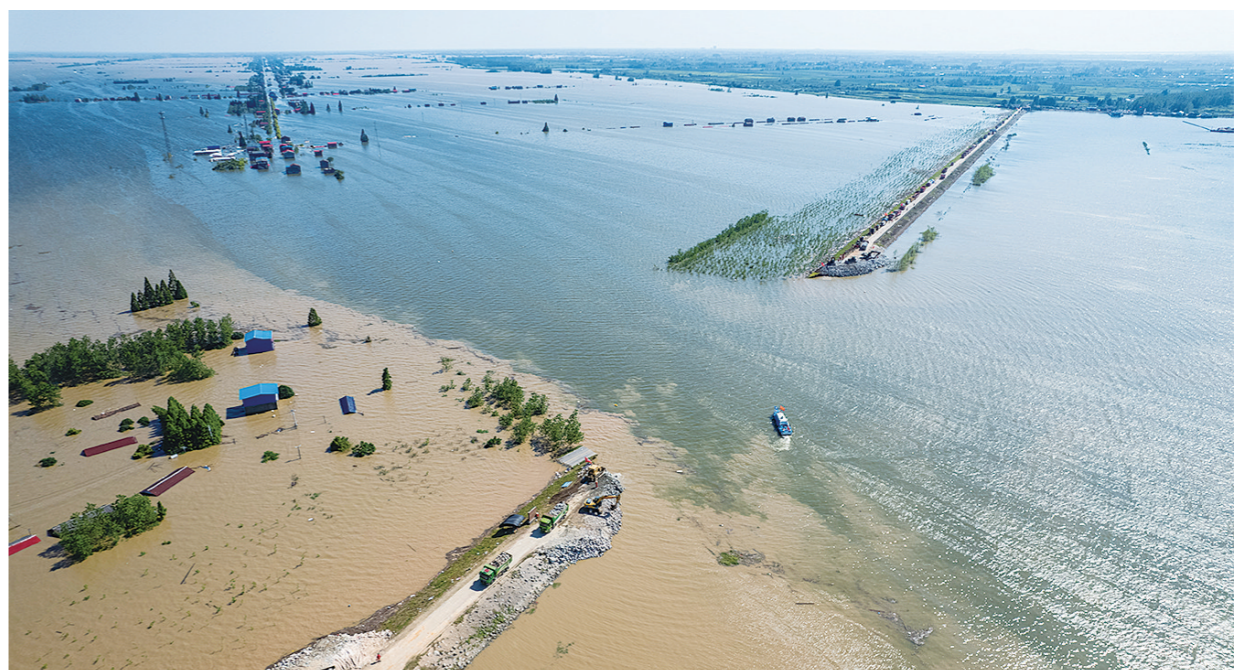
7月6日，抢险队伍在进行堵口作业(无人机照片)。新华社记者 陈思汗 摄
