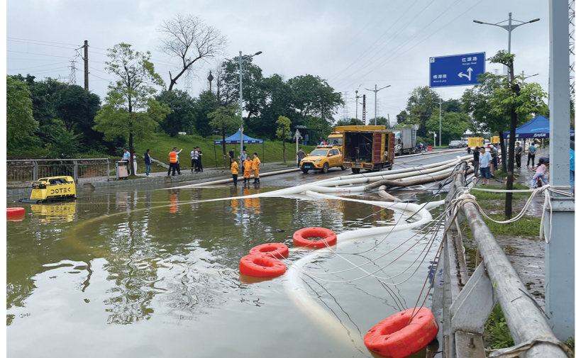
6月27日下午5时，白石港路(人民北路至红旗北路段)仍实行交通管制，因一处涵洞积水，车辆无法通行。图为市政部门调集大型设备抽排积水。记者/刘平 摄
