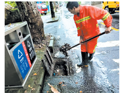
6月25日上午,石峰市政工作人员正在清理新民路雨水篦子及周边的树叶等垃圾。通讯员供图
