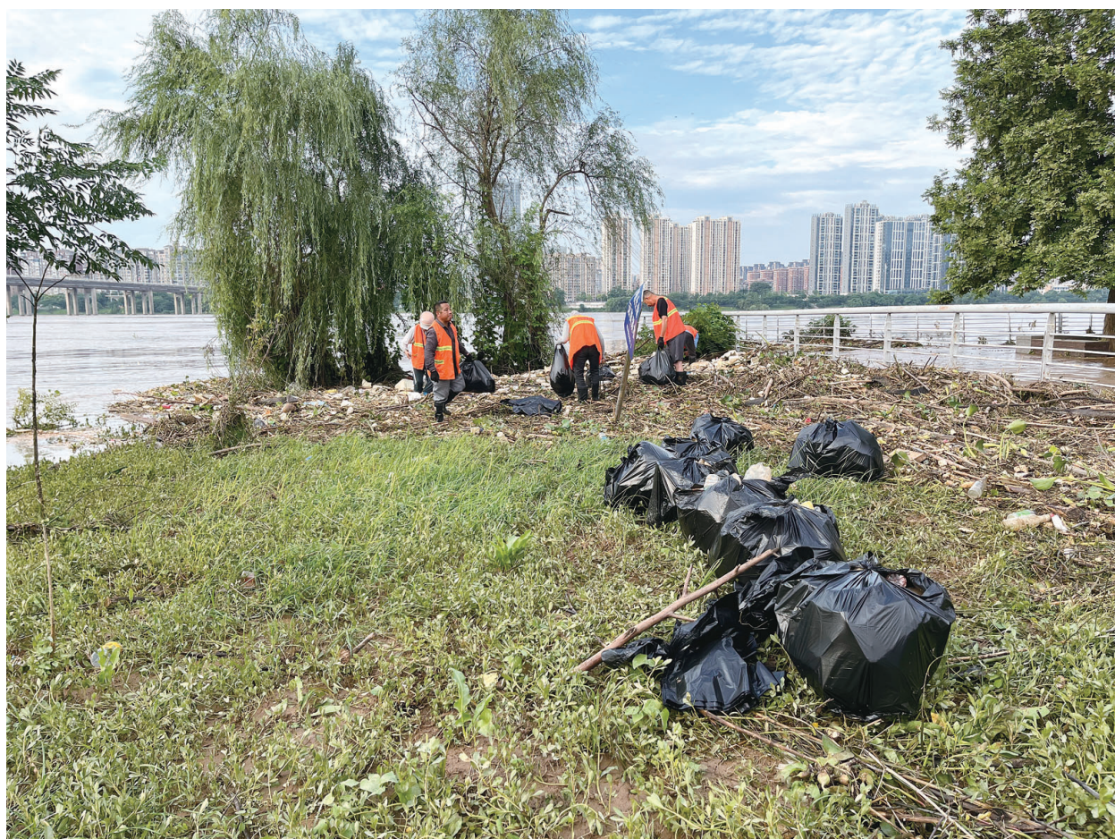
6月21日,石峰区响石岭街道白石港社区,环卫工人在忙着对洪水消退后的被淹区域开展清淤保洁工作。自6月20日洪峰过境后,响石岭街道办事处组织保洁队伍连夜对白石港老街一带的被淹路段开展清淤保洁作业,帮助居民恢复生活秩序。
