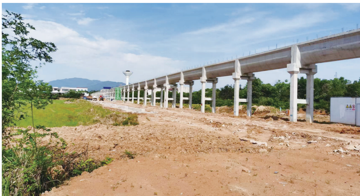
重建后的班竹坑渡槽,解决了下游5.94万亩农田的灌溉问题。 通讯员供图
