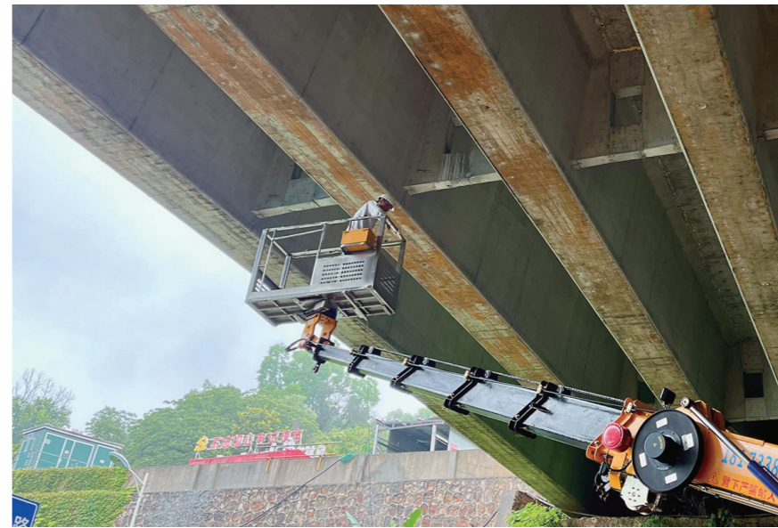
响田桥下,技术人员正在布置检测点。 记者/张威 摄
