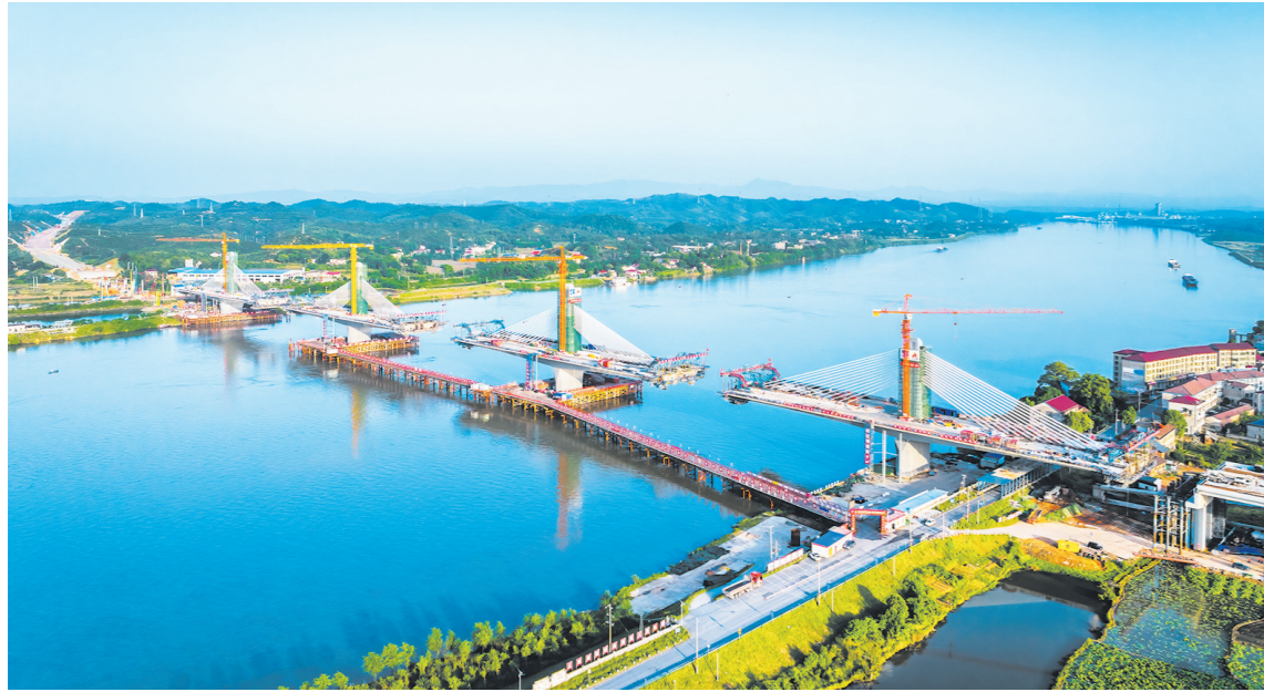
建设中的醴娄高速株洲湘江特大桥。通讯员/咏洲 摄
