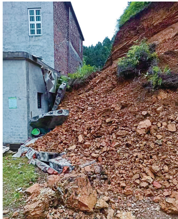
4月初,茶陵县湖口镇北斗村成功避险一处灾情,图为山体滑坡发生现场。 通讯员供图。
