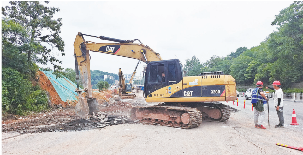
响田大桥拓宽改造连接线工程项目施工现场。株洲日报全媒体记者/廖明 摄
