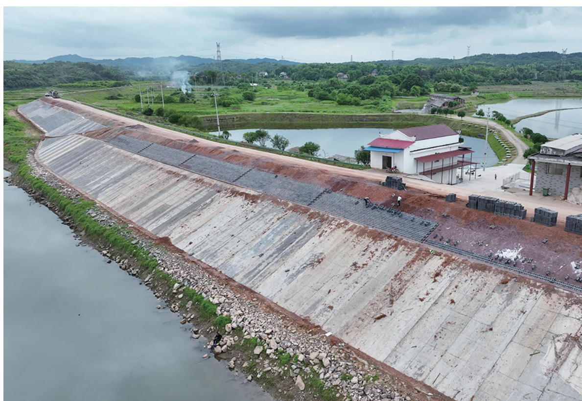
渌水左岸渌口区高沙洲防护圈项目施工现场。曾俊敏 摄
