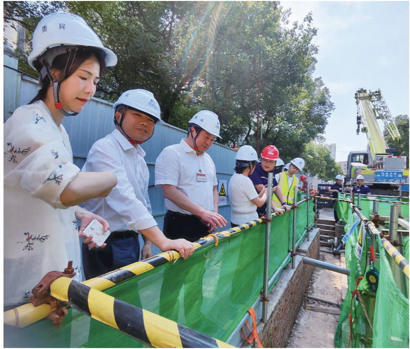
5月16日,四级人大代表专题视察龙泉片区雨污分流施工情况。 记者/杨凌凌 摄
