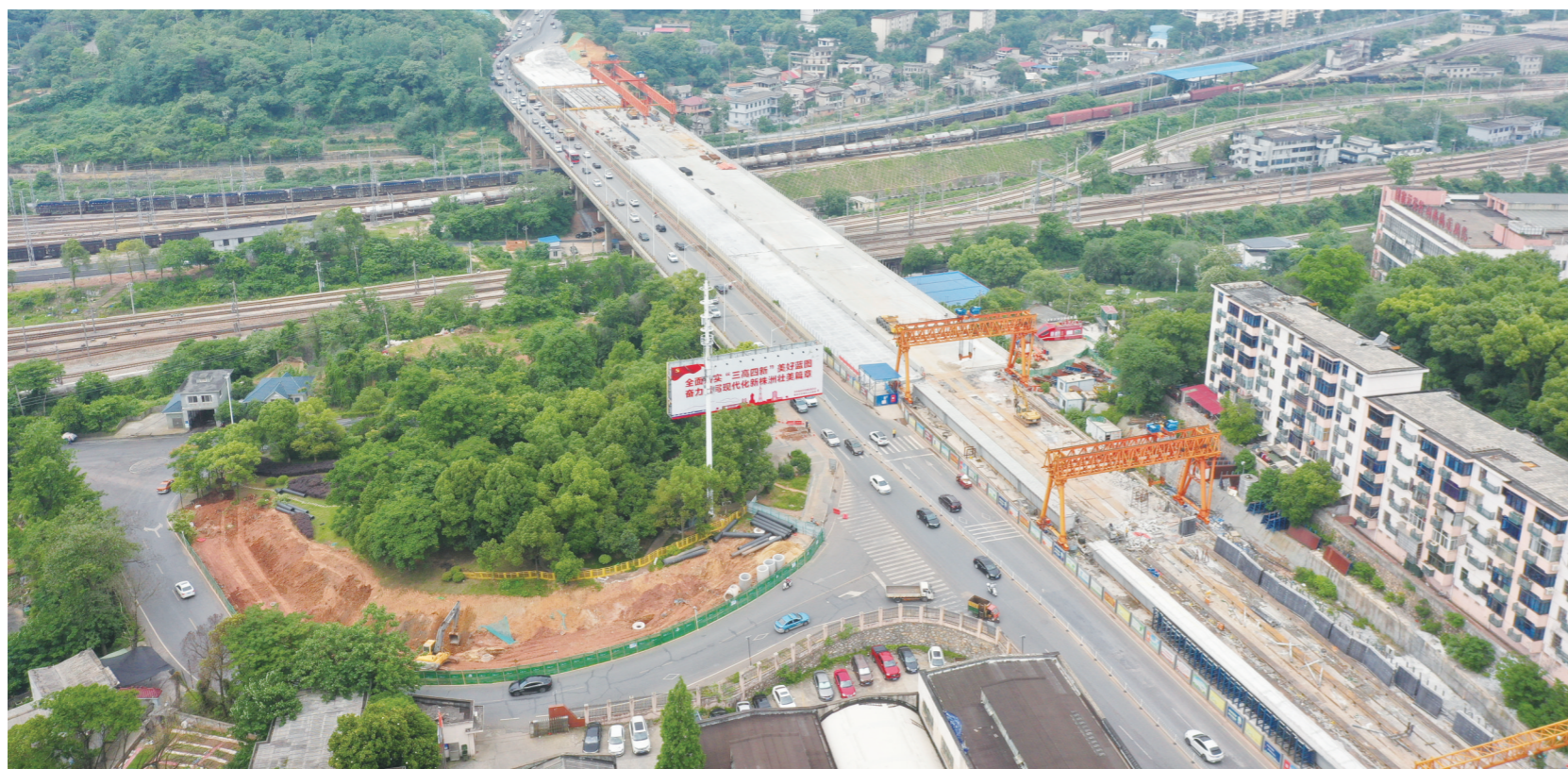
昨起，响田大桥进入封闭施工。5月17日20:00至5月20日6:00，响田东路(响田路中石油加油站至田心立交段)主线实行全封闭施工。新桥梁预计5月下旬完成箱梁架设，6月底具备通车条件。图为昨天上午响田大桥的施工现场图。
