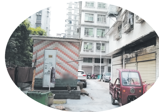
合泰鑫城小区变电房周边治理后环境明显改善。 受访者/供图
