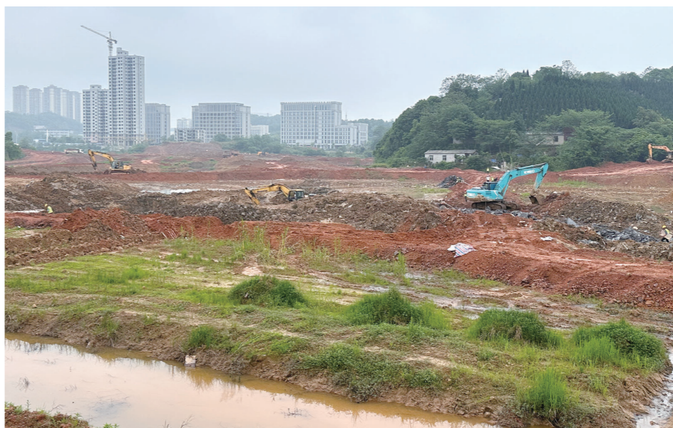
各种大型工程设备正在对公园“塑体”。记者/张威 摄
