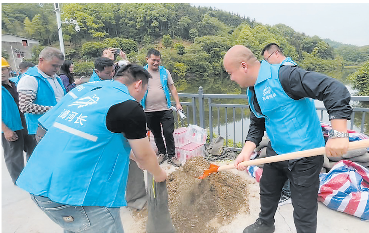
抢险队员演练紧急装填沙袋,对水库进行除险加固。 记者/俞强年 摄
